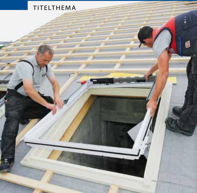
Einbau des ebenfalls mit Expansionsbändern bestückten Fensterrahmens in die Dämmzarge
