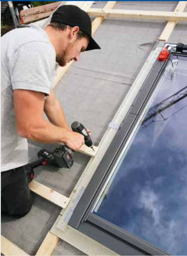
Dachlattenmontage auf der Dämmzarge
