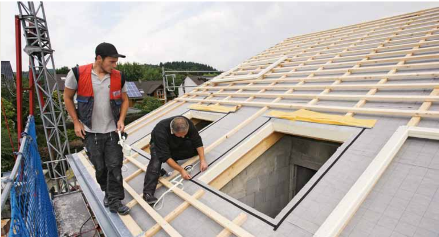
Expansionsbänder am Dachausschnitt zur Abdichtung der Dämmzargen
