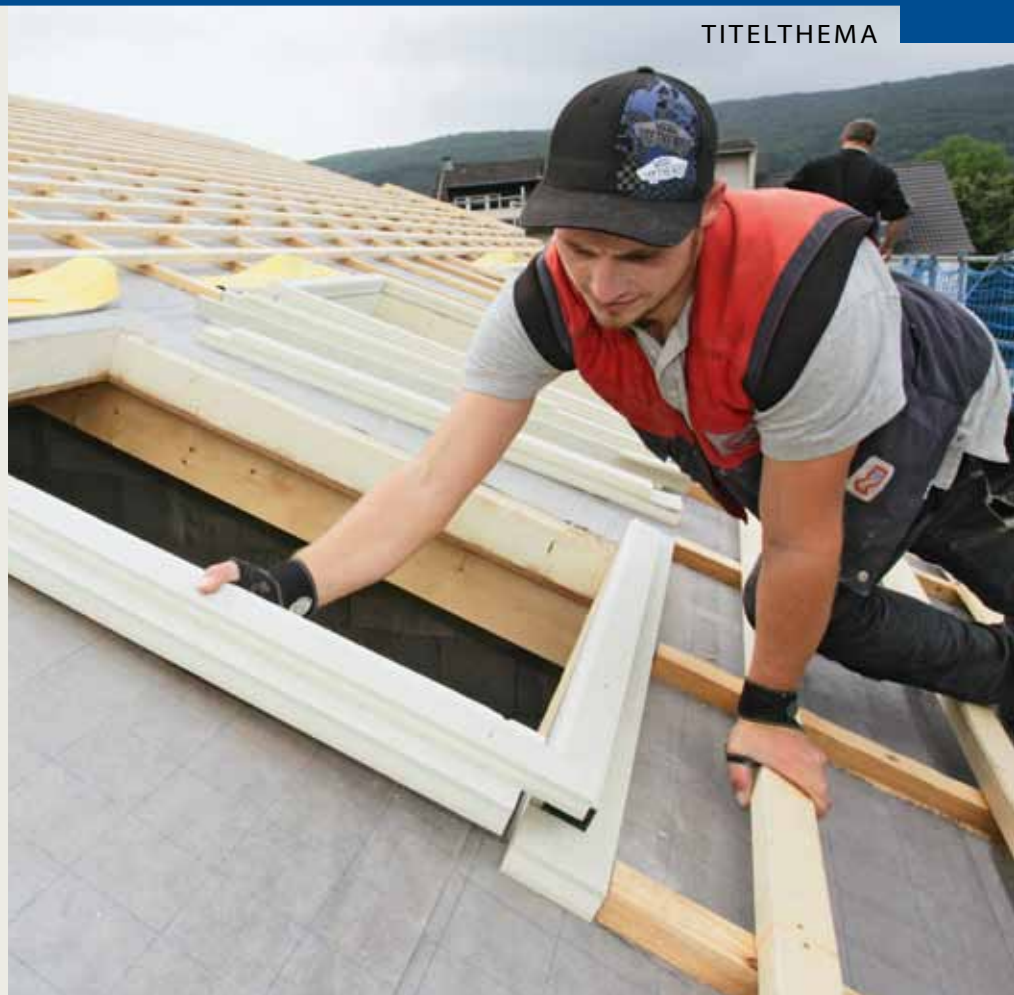
Die Einzelteile der Dämmzargen werden rund um die vorbereiteten Fensteröffnungen ausgelegt.
